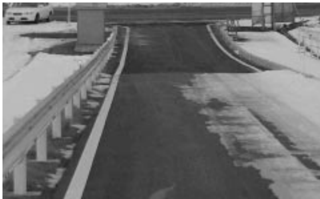
Fig. 1. The result of de-icing installation work on a part of road Ryc. 2. Wynik funkcjonowania instalacji odladzania fragmentu jezdni
