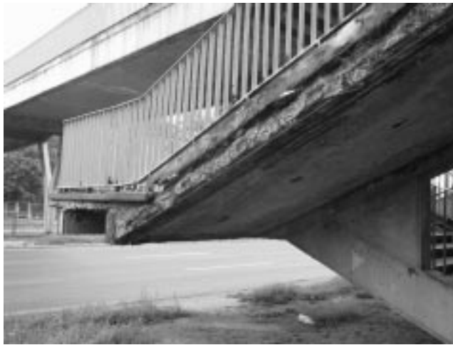
Fig. 5. The passage for pedestrians destroyed by salt activity Ryc. 5. Kładka dla pieszych zniszczona wskutek działania soli
