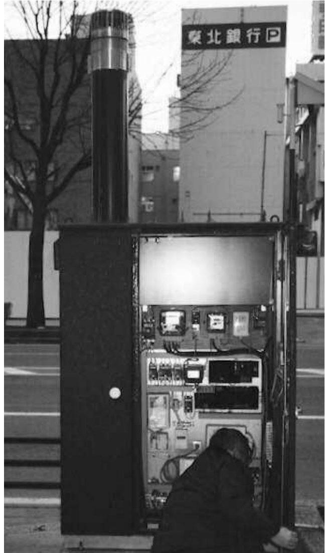
Fig. 4. The control box and exhaust chimney connected to underground boiler of de-icing system Ryc. 4. Urządzenia kontrolne i komin usuwający spaliny dla podziemnego bojlera zasilającego system odladzania
