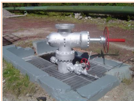
Figura 20. Vista actual de las instalaciones superficiales del pozo Az-47 (izquierda) y logística de operaciones para prueba de inyección en este pozo (derecha).
