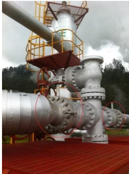
Fig. 3.- Placa Orificio para Regular Presión en Boca de Pozo
