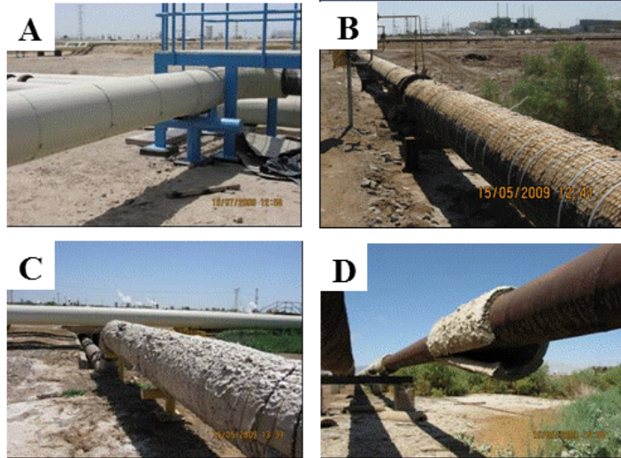
Figura 2. Clasificación de los materiales aislantes de la red de tuberías del CGCP
