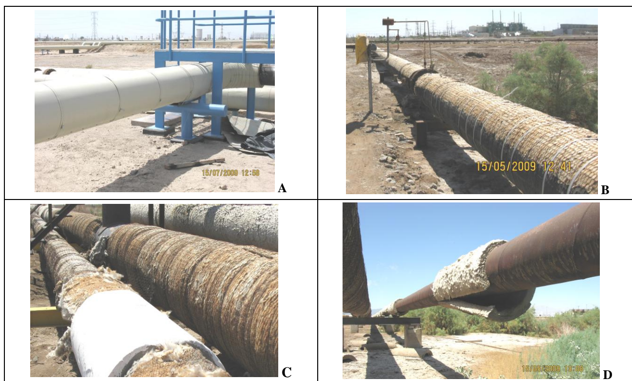
Figura 1. Fotografías de campo representativas de cada clasificación del estado físico del aislante: A) Nuevo o completo; B) Bueno, sin lámina; C) Regular ; D) Ausente o destruido totalmente.
