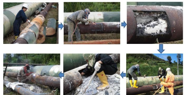
Gambar 3.1 pekerjaan pembersihan pipa
