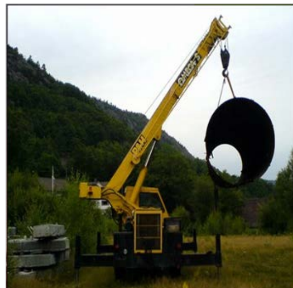
Gb.5 : Kegiatan konstruksi pipa uap panas bumi
