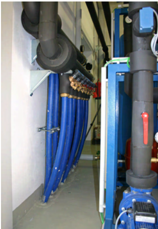
Picture 2: EDEKA Aktiv-Markt Koch, Schöenberg – Geothermal Manifold
